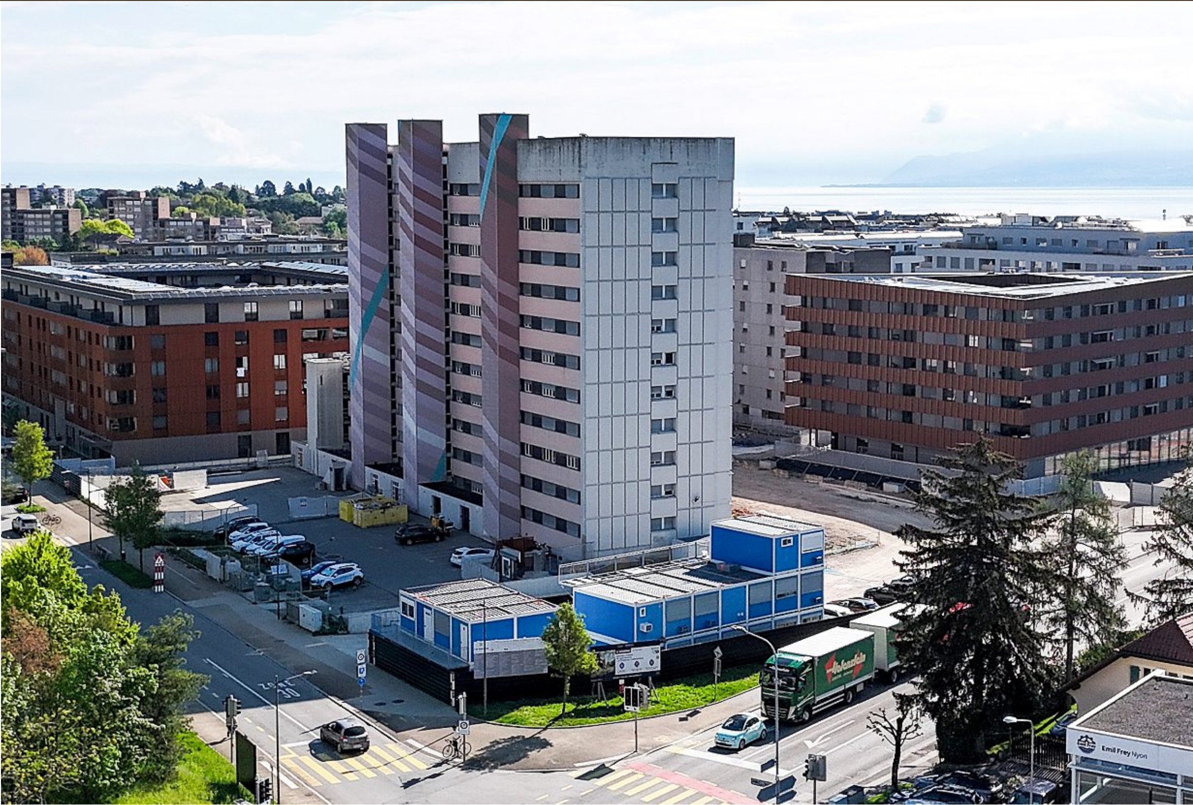
La Suettaz, bâtiment facilement reconnaissable à Nyon, a parfois été surnommée «le mur de la honte». Avant la démolition des deux premiers tiers de la barre locative, celle-ci comptait 176 appartements.
