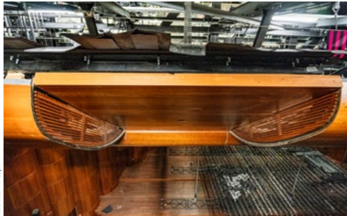
L'Auditorium Stravinski et son plafond, qui abrite toute la technique électrique et phonique ultra-délicate, sont protégés par de grandes parois en bois et des bâches afin de garder à l'intérieur une température minimum. Dans le cadre des mesures de protection incendie, toutes les poutres en acier sont revêtues d'un habillage feu, soit avec du béton, soit avec des matériaux ignifuges.
