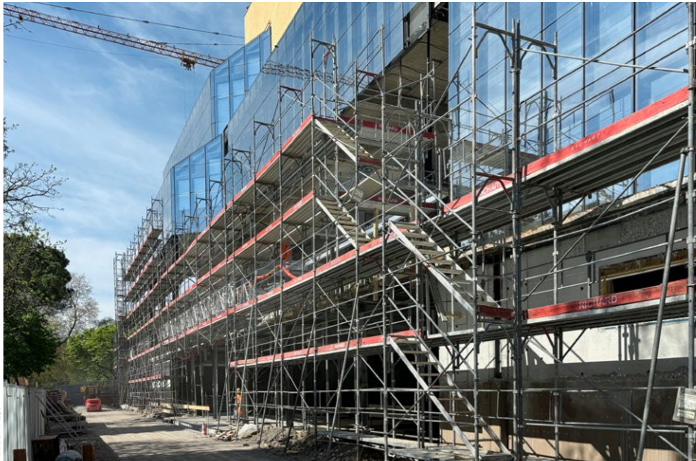
Les grandes baies vitrées vont toutes être remplacées par des verres triple vitrage pour assurer une meilleure isolation thermique.
