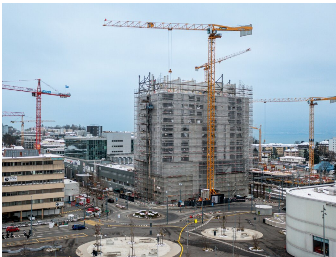
Le bois n'est pas visible depuis l'extérieur. ©CCHE
