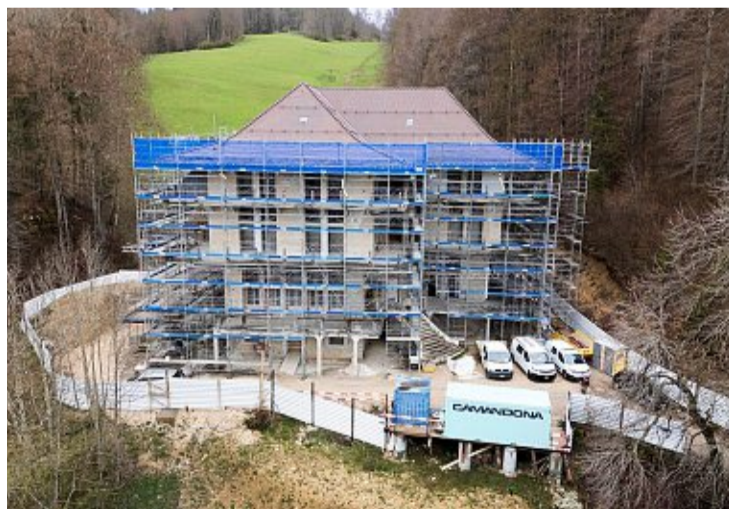
Le chantier de la villa construite au début du XX e pour Maurice Bunau-Varilla, patron du quotidien français «Le Matin», a débuté en 2024.
