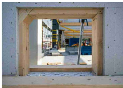
Les éléments porteurs en bois sont encapsulés dans un revêtement en fibre de bois et en ciment compressé. Florian Cella
