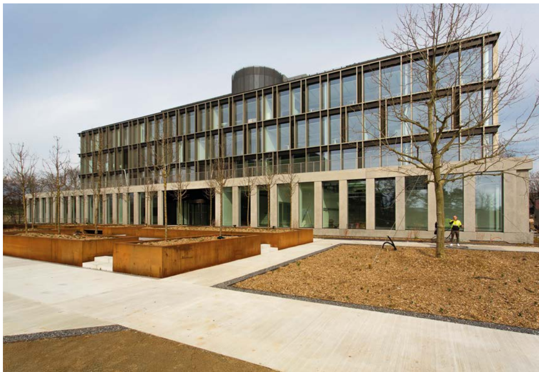
Le bâtiment vise la très haute performance énergétique. Frank Mentha
