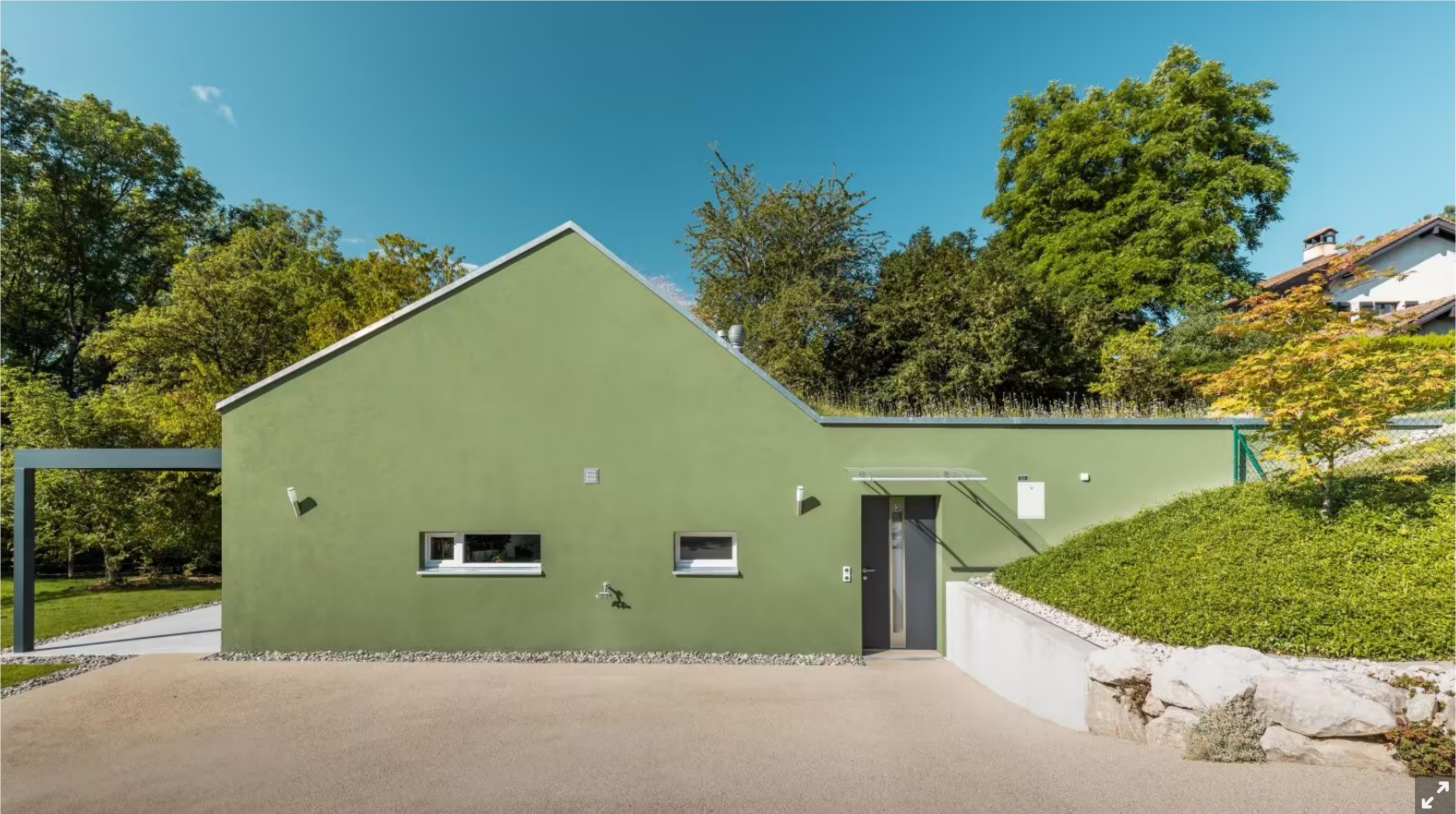
Un projet de tiny house, réalisé par le bureau d’architectes CCHE Nyon SA. — © Société Fullframe
