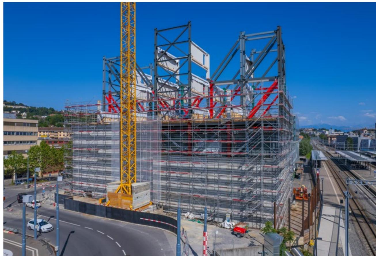
800 t de charpente métallique stabilisent la tour. Trois fermes à treillis sur trois niveaux de triangulation, représentant 9 étages, sont en cours d'assemblage l'une après l'autre depuis le mur porteur ouest de la tour. Elles sont ensuite ripées le long des murs nord et sud du nouveau bâtiment grâce à quatre vérins hydrauliques.
